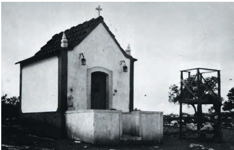
Táto kaplnka bola ľuďmi vybudovaná v roku 1918 na mieste zjavení.
